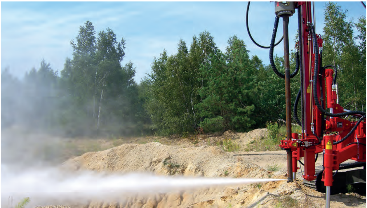
KLEMM HDI-Ausrüstung KLEMM jet grouting system
